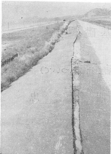
写真4 堤防の沈下と亀裂 (FD+140附近)
