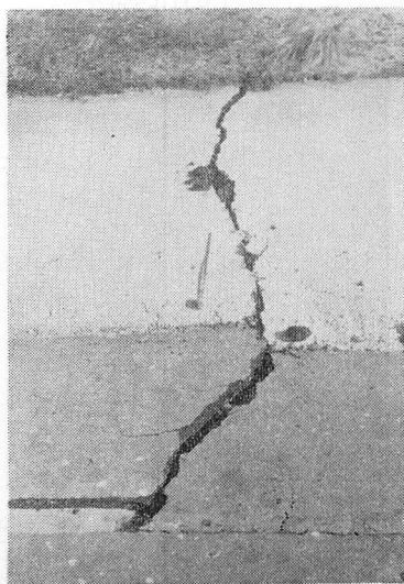
写真3 堤防の亀裂
