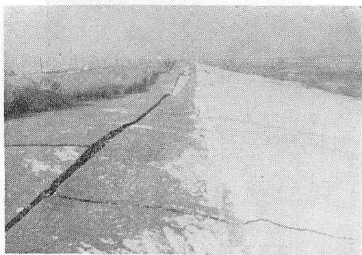
写真5 堤防の沈下と亀裂 (FD+550附近)
