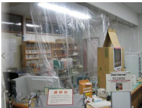
図2 図書館カウンターへビニール製仕切りの取付 天井取付部は、目玉クリップ・結束バンド・両面テー
